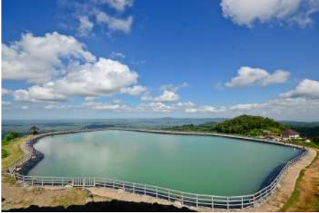
อ่างเก็บน้ำ Water reservoir
