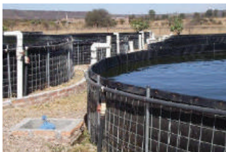
บ่อเก็บน้ำ Water management
